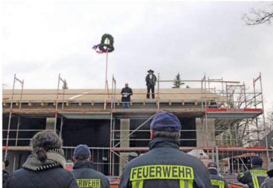
Eine neue Herberge für die Honerdingener Feuerwehr: Am vergangenen Freitag feierten die Verantwortlichen Richtfest an der Dorfallee. Läuft alles nach Plan, könnte der Neubau in rund einem halben Jahr bezugsfertig sein. Foto: Reinhold
