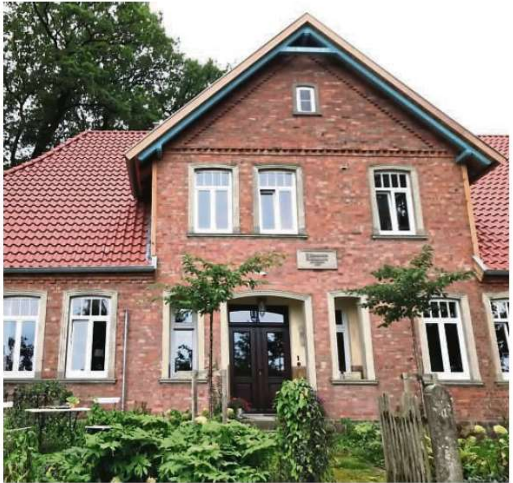
Bei diesem Gebäude wurden mit Mitteln der Dorfentwicklung das Dach und die Fassade saniert.
