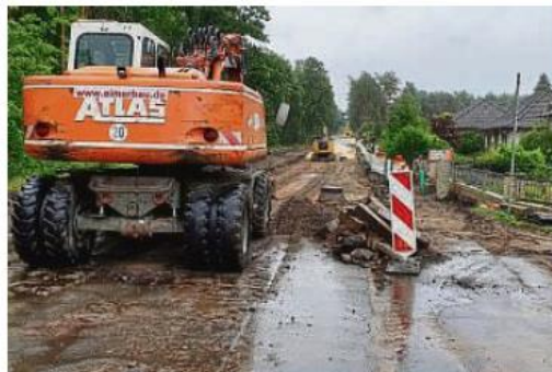
Endlich geht es im Fuhrenkamp in Beetenbrück mit den Bauarbeiten los. Auch die Stichstraßen sollen erneuert werden. Fotos (2): mü
