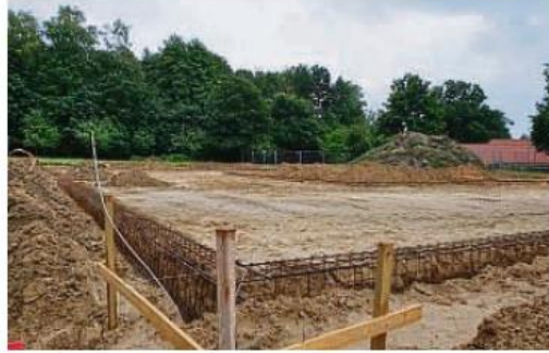
Die Schule Vorbrück erhält einen Neubau für eine Ganztagschule. Bald kommt der Beton für die Platte.
