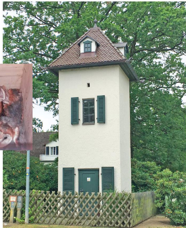
Vom Schandfleck zum Schmuckstück: Das ehemalige Trafo-Häuschen in Bockhorn erstrahlt seit einigen Jahren in neuem Glanz – und bietet nun einer Schleiereulenfamilie ein Zuhause. red (2)
