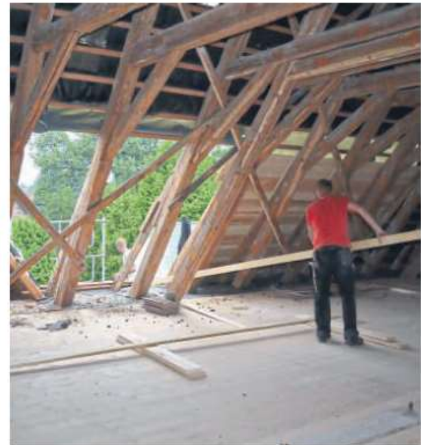
Das Gotteshaus erhält unter anderem ein neues Dach.
