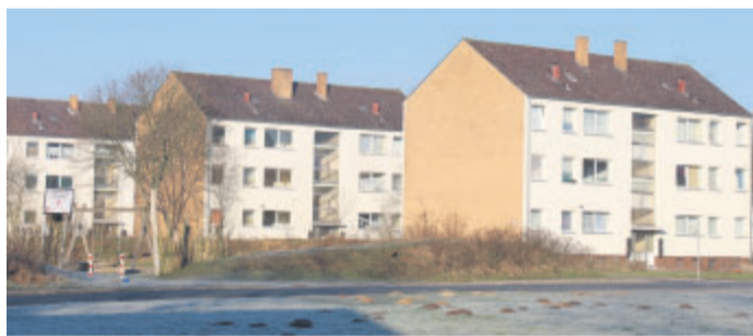
Stadtumbaugebiete beschlossen: Unter anderem im Siedlungsbereich „Weinberg“ will Bad Fallingb. Wohnblocks kaufen und abreißen. ei
