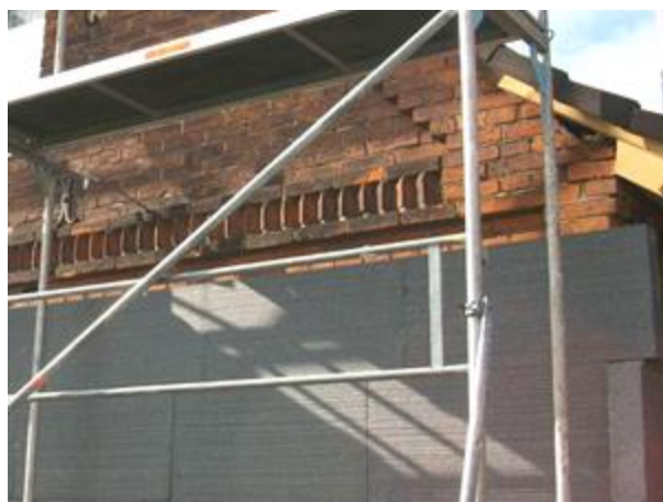
Abb. 27 Negativbeispiel: Außendämmung verdeckt historische Bausubstanz
