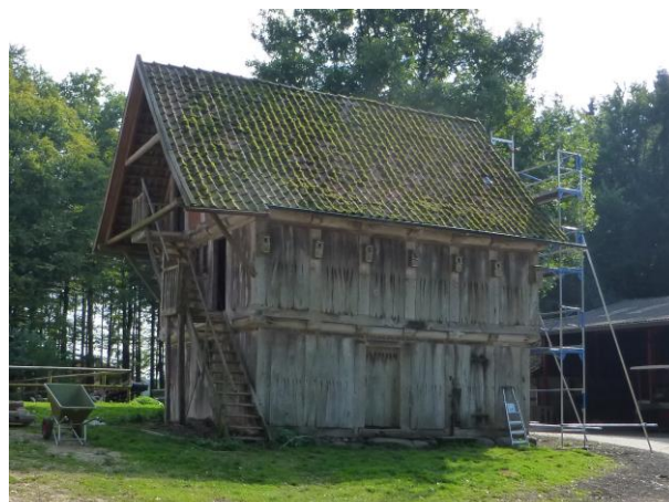
Besondere Bauform - der 2-geschossige Holzspeicher
