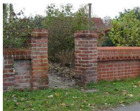
Abb. 32 Backsteinmauer, teilweise erneuert
