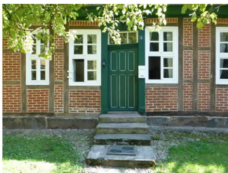
Abb. 17 Fenster/Haustür im Fachwerk
