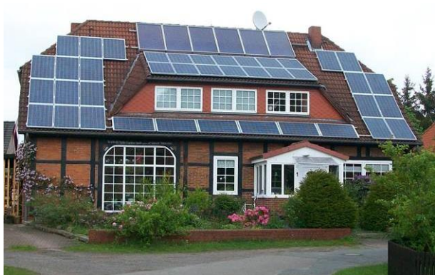
Abb. 26 Negativbeispiel: Weder farblich noch gestalterisch abgestimmte Aufdach-Anlage
