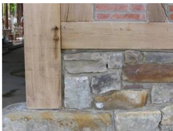
Abb. 4 fachgerechte Sanierung mit Eiche (neu), Naturstein und Backstein (alt)
