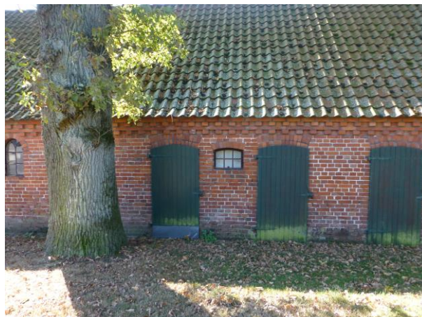
Holztüren (außen angeschlagen) mit Rundbogen
