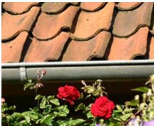
Abb. 9 Die Hohlpfanne als Sinnbild einer langlebigen Dacheindeckung
