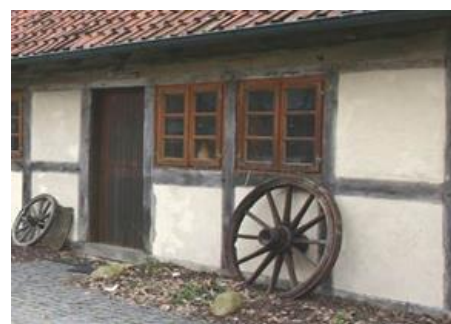
Abb. 16 Lehmputz im Fachwerk
