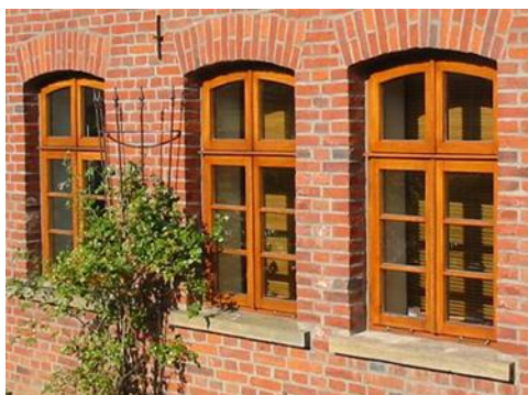
Abb. 19 Fenster im Mauerwerk
